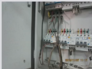
乱接、乱拉电线
